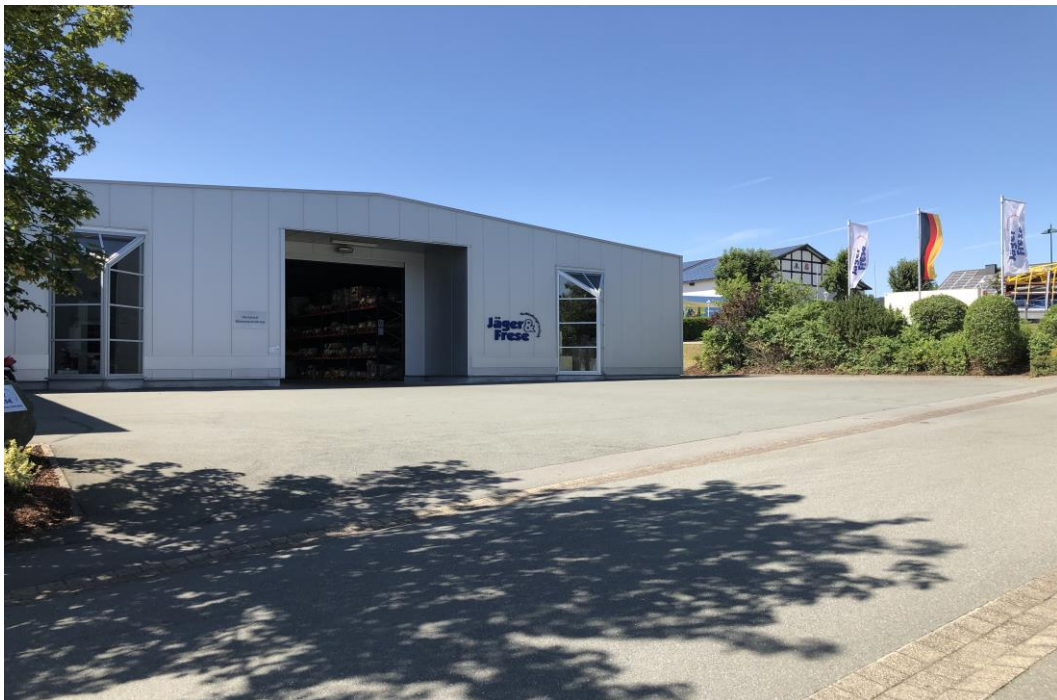
Abb. 8 – Blick auf die Hallen 2 mit Rangier- und Beladefläche für Lkw, westlich der Straße ‚Beuke‘, nördlich noch der abgegründete Parkplatz (zukünftiger Standort der Halle 3), im Hintergrund die Schützenhalle Oberschledorn
