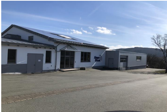
Abb. 55 - Blick auf das Verwaltungsgebäude mit den beidseitigen Werkstattgebäuden [Beuke 10], Straße ‚Beuke‘ mit 3-lagigem Betonsteinpflaster als Regenablauffrinne ohne Schrammbord und übergangslos asphaltiert die vorgelagerten Parkplätze, Tore mit Lager-, Be- und Entladefläche sowie zum Transport in die Halle 2 der Firma ‚Jäger & Frese‘
