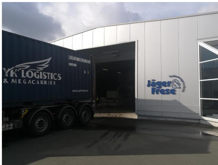
Abb 66 - Blick in die Lagerhalle 2
