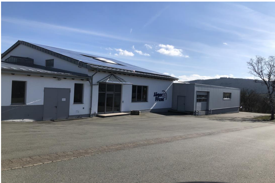
Abb. 7 – Blick auf die Verwaltung/Büro und den nebenstehenden beiden Fertigungsbetriebe mit Straße ‚Beuke‘
