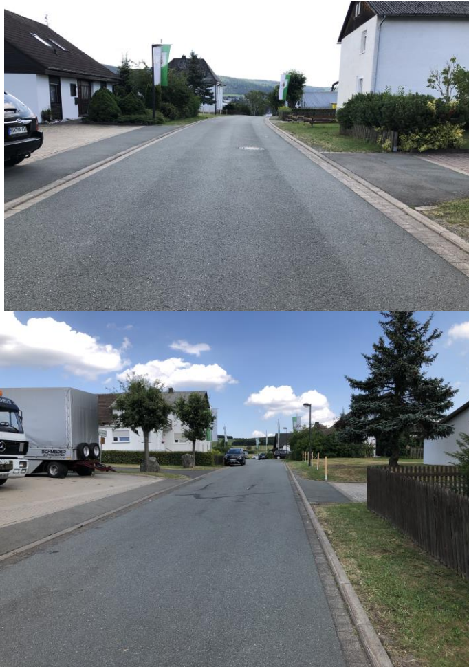
Abb. 59 – Erschließungsstraße ‚Beuke‘ mit privat angelegten/angedeuteten begleitenden Fußwegen / Rasenflächen, links Parkplatz der Schützenhalle (Lkw stehen für eine Veranstaltung), rechts ‚Beuke 12‘
