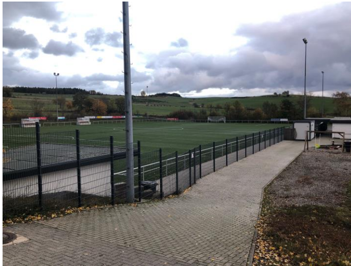
Abb. 50 – Sportanlage (Fußballplatz mit Kunstrasen und Flutlicht) mit Umkleidegebäude/ Gaststätte und zwei Nebengebäuden des ‚SV Oberschledorn 1923 e.V.‘
