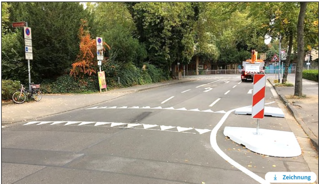
Abbildung 11: „Gehwegnasen“ oder „vorgezogene Seitenräume“ durch Fertigteile der Fa. Lüft Verkehrstechnik)
